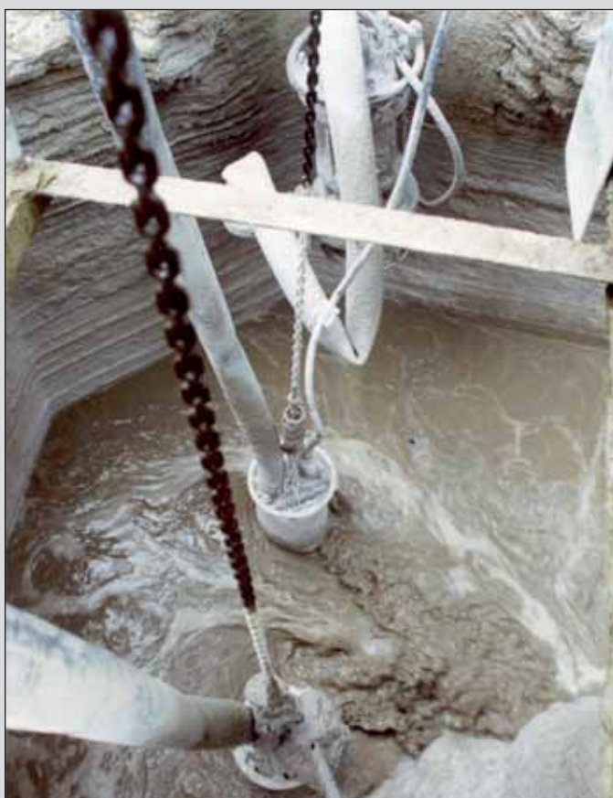
ET10 et DP10 Usine à béton
