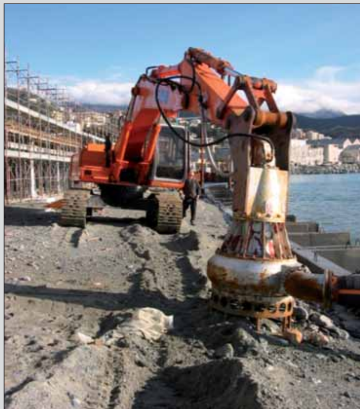
DPH300 Travaux publics
